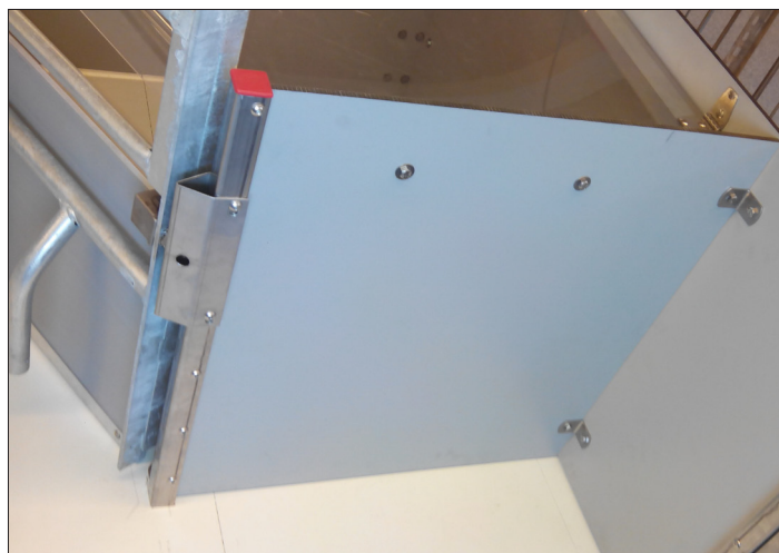
FT-30 stien kan konstrueres i 10 mm fiberplader.
